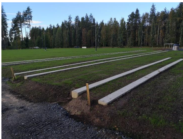
Kuva 3 Anneli Salo: hautamuistomerkkien aluskivipalkkien toteutuskuva Kokkokankaan hautausmaan laajennusosan suku-uurnahauta-alueelta
