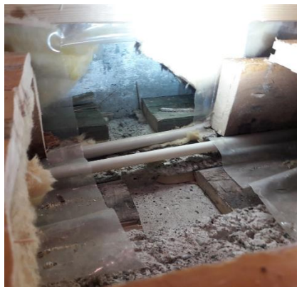
Kuva: Alapohja ja perusrakennetta. Betonivaluun on asennettu tartuntalauta.
